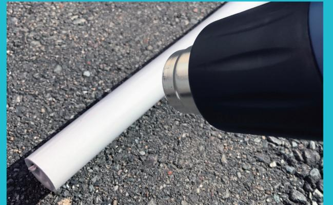
中の空気を外に押し出すように先端部分から熱風をあてます。やけどに注意。
