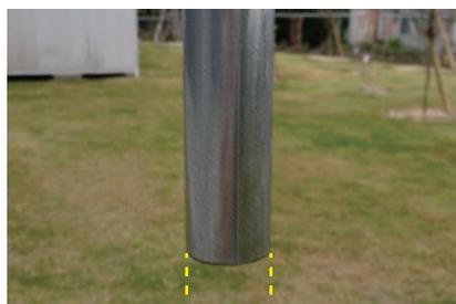
アーチパイプの錆びた箇所を切断し、抜いてしまいます。
