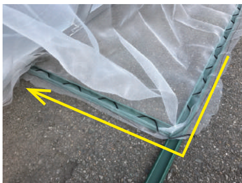
⑥捨て張り部分からネットをくの字に折って固定します。
