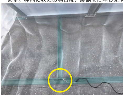
④次にネットの下側を固定します。始点は捨て張り部分からです。
