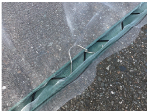
②ビニール押えをフィルム止材に取付けます。
