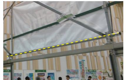
実際に取り付けてみます。まず最初に適当な長さのパイプを妻柱と直角に取り付けてください。
