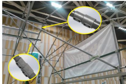
位置を決めたら突っ張った状態でパワーレジストの金具のボルトを締めます。
