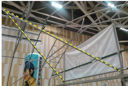
妻面に取り付けたパイプと峰パイプを繋ぐように、パワーレジストをユニバーサルで固定します。
